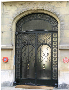
porte d'entrée de l'immeuble
