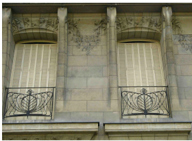
détail du premier étage.
