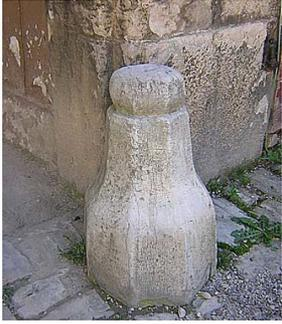
Le chasse-roue est un petit obstacle, formé par une borne, un arc métallique, etc..., placé à l'angle d'une construction ou au pied d'une porte cochère dans le but de protéger ces parties des chocs des roues des voitures. Les chasse-roues peuvent être réalisés en pierre, en métal, en grès ou granit, et certains reçoivent un superbe décor sculpté. L'équivalent féminin du chasse-roue est la bouteroue.
