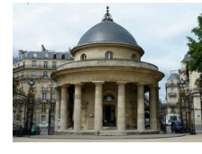
Barrière de la rotonde de Chartres, par Claude-Nicolas Ledoux pour l'enceinte des Fermiers généraux, 1786-1792, parc Monceau, Paris.
